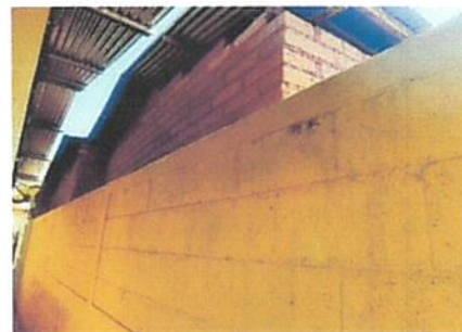
foto 12: pintura de muro interior y exterior del centro educativo
