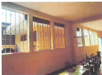
foto 11: pintura de muros interiores y exteriores del centro educativo
