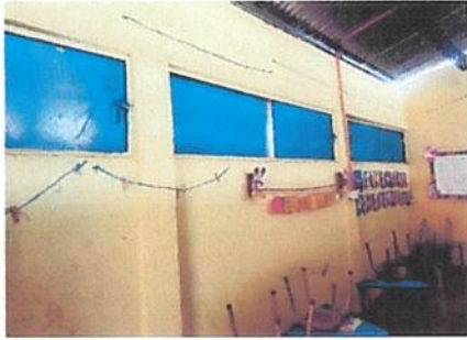
foto 7: suministro e instalacion de ventanas pvc y balcones
