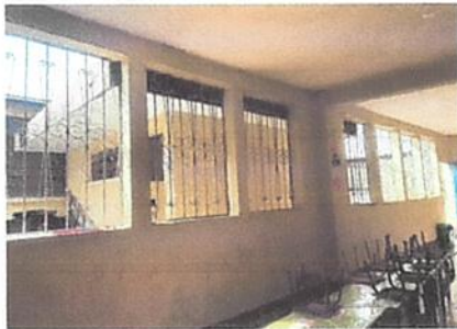
foto 5: suministro e instalacion de ventanas pvc
