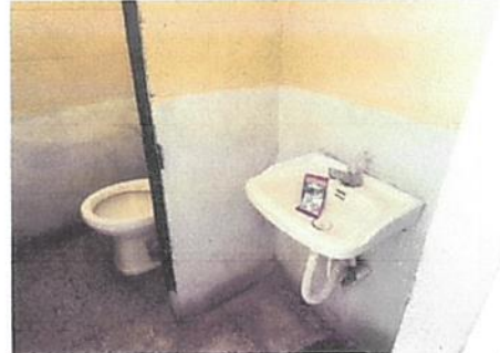
foto 2: sustitucion de baños y lavamanos e instalacion de urinario, mejoramiento de puerta y ventanas
