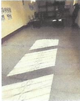
foto 3: sustitucion e instalacion de piso ceramico antideslizante en modulo 2 y 3
