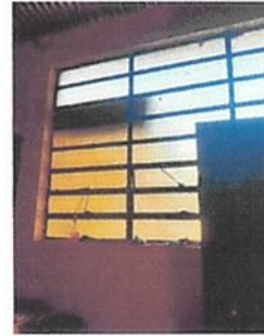
foto 8: suministros e instalacion de ventanas
